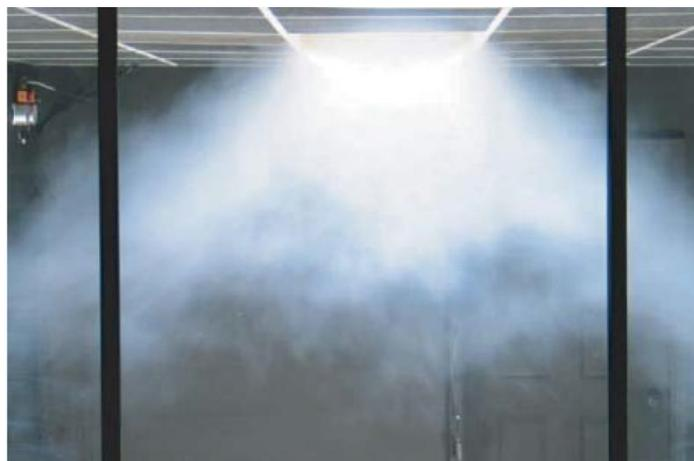
Пример распределения воздушных потоков через текстильный диффузор.
